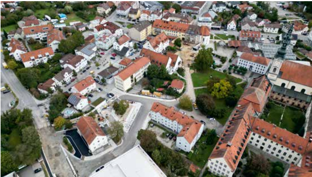
Anhand von Drohnenbildern können wir uns und Ihnen einen wunderbaren Überblick über die stets fortschreitenden Bauarbeiten aller Baustellen im Ortszentrum des Gemeindegebiets Fürstenzell übermitteln. (Foto: Wagmann)
