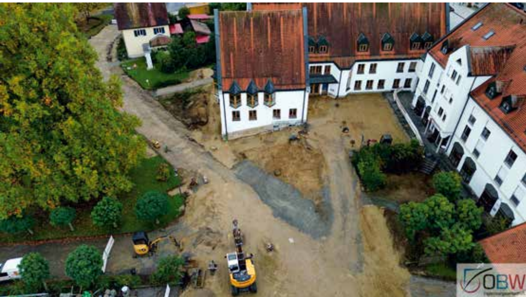
Auch der barrierefreie Rathausvorplatz nimmt Gestalt an und die Bauarbeiten schreiten stetig vorn. (Foto: Ebner)
